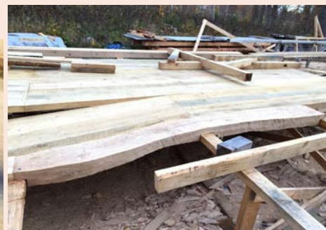
Halvklover, där timret klyvs ger konstruktionsfördelar då virkets geometri och fiberriktning samspelar. Grenarnas svängda former har utnyttjats för att ta upp rampens lutningsförändringar.
