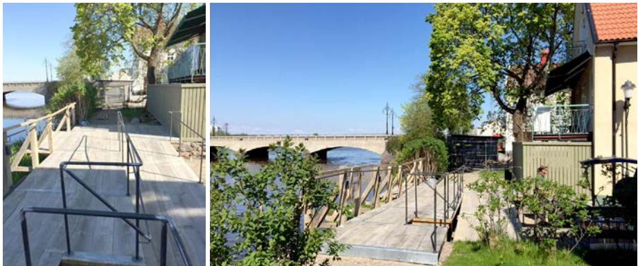
Montering av räcken och handledare
