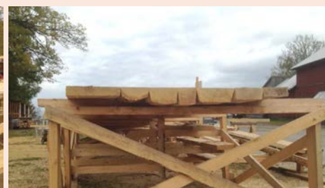
Halvklover, där timret klyvs ger konstruktionsfördelar då virkets geometri och fiberriktning samspelar. Grenarnas svängda former har utnyttjats för att ta upp rampens lutningsförändringar.
