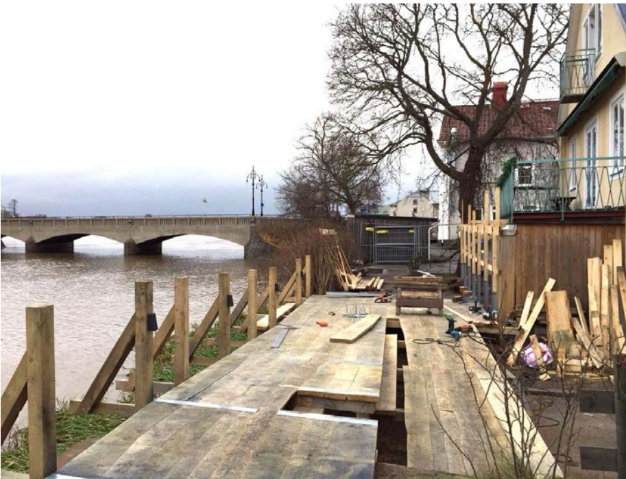
(FIGUR 26) MARIESTAD – TIDANPROMENADEN, FULLSKALEMODELL – MONTAGE AV TRÄDÄCKET VID TRÄDGÅRDSGATAN
