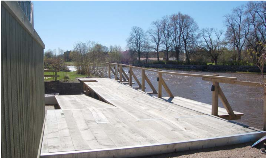
Träddäcket i väntan på anslutningsarbeten och montering av ledstänger
